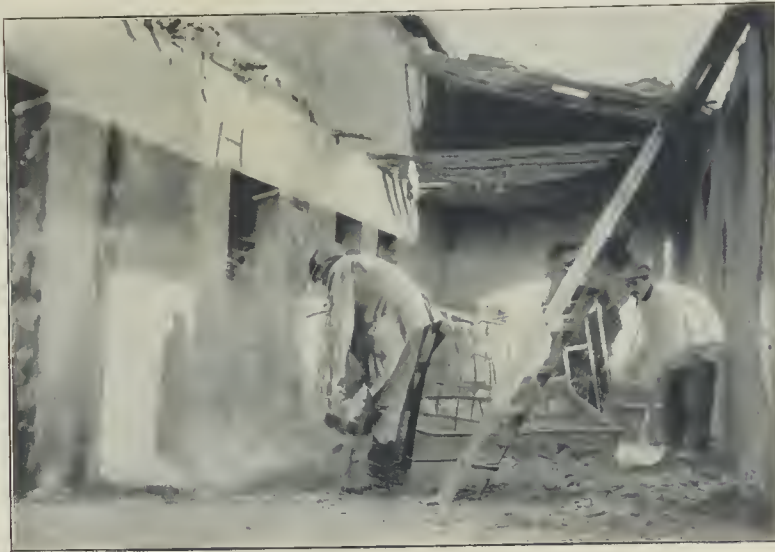
El Escorial.—Incendio del Real Colegio de Estudios superiores, de los P.P. Agustinos Trabajos de extinción en una de las naves del Colegio. (De fotografía de Asenjo.)
